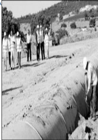
Un obrero trabaja en una de las canalizaciones ante el paso de las autoridades.
